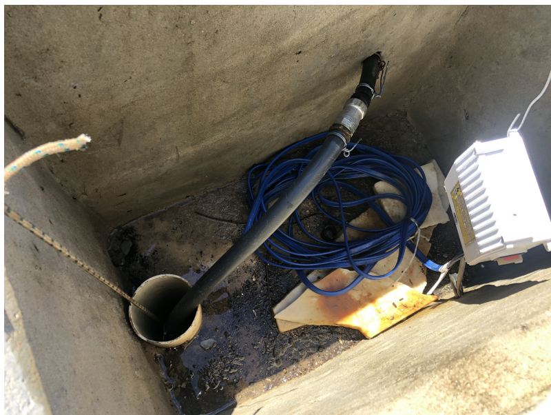
Detalles del interior y de caseta de perforación c/ bomba sumergible
